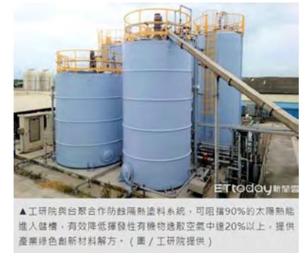
▲工研院與台聚合作防蝕隔熱塗料系統，可阻擋90%的太陽熱能
