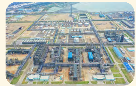
蒸氣裂解裝置空拍圖
