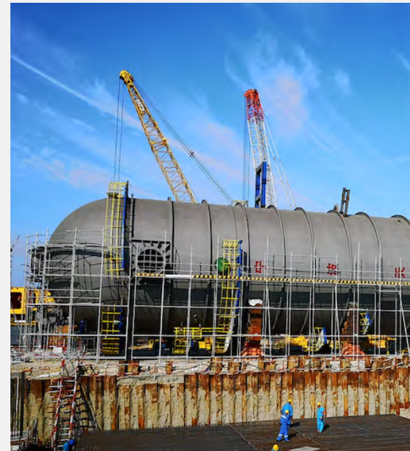
蒸氣裂解急冷油塔安裝
