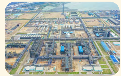
蒸氣裂解裝置航拍圖
